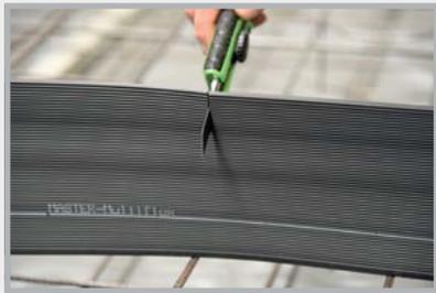
Das standfeste Fugenband lässt sich mit einem Cutter leicht zuschneiden.
